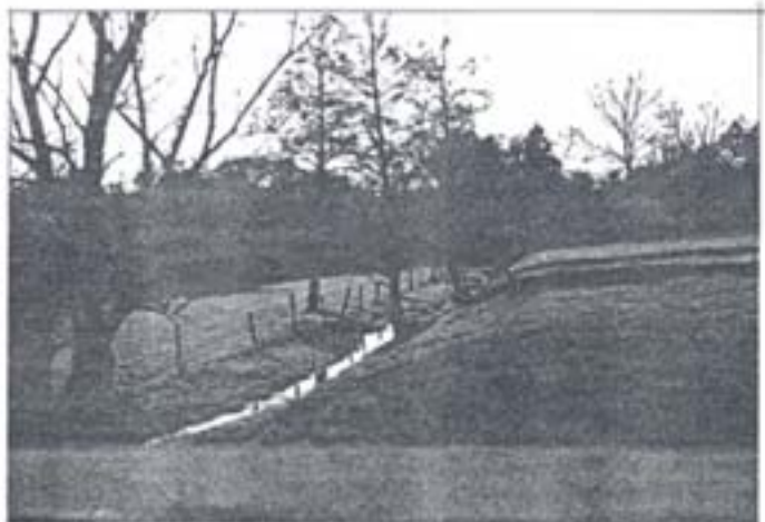
Der Zulaufgraben zur ehemaligen Wasser- burg Haus Düssel
